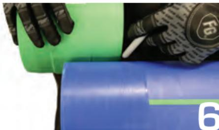
Marque la tubería a la mitad de la profundidad del accesorio. Las dos secciones de la tubería se encontrarán en el centro.
