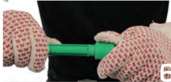
Inserte inmediatamente\* la tubería en el accesorio. Presione la tubería hasta que los anillos del cordón se encuentren dentro del tiempo de fusión (columna G).
