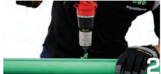
Si el orificio es demasiado pequeño, taládrelo con cuidado. Utilice una broca de  $\frac{1}{4}$ " para el cabezal de  $\frac{5}{16}$ " y de  $\frac{3}{8}$ " para el cabezal de  $\frac{7}{16}$ ".
