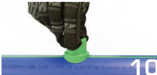
Coloque el accesorio en el orificio y manténgalo en su posición. Aplique solamente la presión suficiente para mantener el contacto entre las superficies calentadas.
