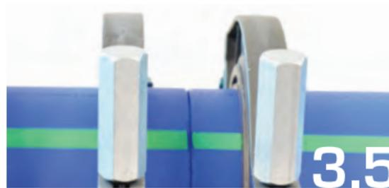
Alinee las líneas de impresión/pintura de cada tubería como se desee (no es necesario) y ajuste las abrazaderas.
