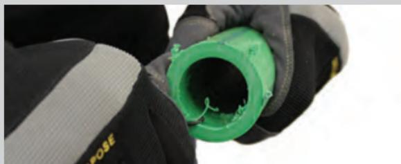
Elimine los residuos producidos por el corte. Con frecuencia pueden retirarse simplemente con la mano. Es posible que tenga que cortarlos cuidadosamente con una cuchilla, una herramienta para desbarbar o un escariador.
