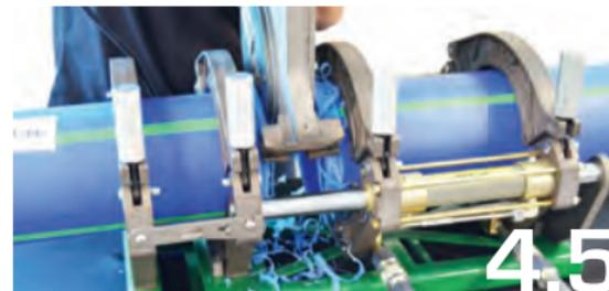
Apague y retire la herramienta de refrentado. No la apague mientras el carro esté cerrado, ya que puede dejar mellas en la superficie de la tubería.
