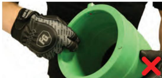
No toque la tubería desprendida o el interior del accesorio. El aceite, la suciedad, el polvo u otros contaminantes pueden arruinar la conexión.
