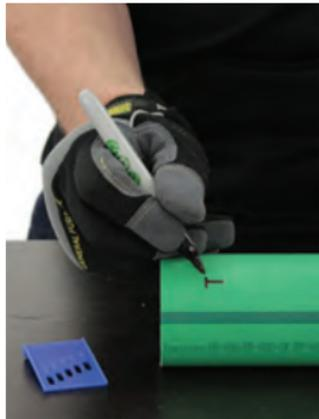
Cuando use la guía de marcado azul, inserte el accesorio al comienzo de la marca, no en el centro. El cordón puede cubrir la marca inicial durante la fusión, por lo que el extremo indica que la tubería se marcó correctamente durante la inspección.
