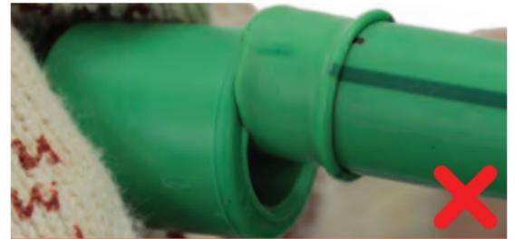
No haga contacto entre la superficie de la tubería y el borde del accesorio. Esta acción aplana los cordones y puede provocar una conexión incorrecta.
