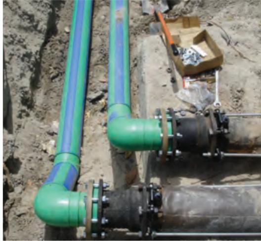
A diferencia de muchos otros materiales de tuberías, el PP-R puede amortiguar el esfuerzo causado por la expansión dentro de ciertos límites. La construcción MF ayuda a mantener la tubería dentro de estos límites en la mayoría de las aplicaciones.
