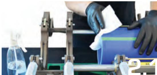
Antes de la fusión, limpie los **extremos de la tubería** para eliminar la suciedad, el polvo, los residuos y demás contaminantes y luego limpie con un paño limpio y alcohol isopropílico (91% o superior).
