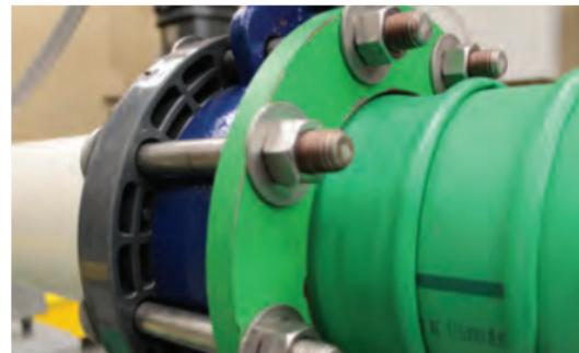
grosor de la junta y el anillo de brida que se utilice. Los pernos siempre deben volver a ajustarse dentro de 24 a 48 horas y después de un cambio estacional u operacional, como enfriamiento a calentamiento
