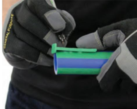
Si el corte queda con un ligero sesgo (no suficiente como para impedir la fusión), haga una sola marca en el lado largo. Use esta marca para evitar una inserción excesiva. La inserción hasta una marca en el lado más corto dejará un cordón incompleto en la tubería. Insertar por el lado largo dejará una leve separación interna, pero no afectará la resistencia de la conexión.
