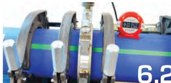
Use un cronómetro y siga el tiempo de calentamiento completo. Muy poco o mucho tiempo de calentamiento terminará en una conexión incorrecta.
