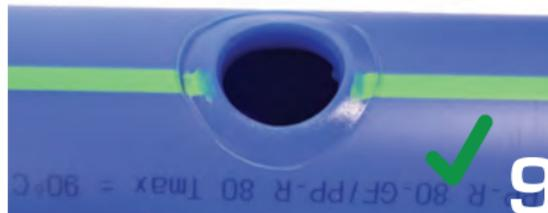
Asegúrese de que el cabezal haga una impresión completa en la tubería. Revise y ajuste el cabezal hasta que se complete el anillo.
